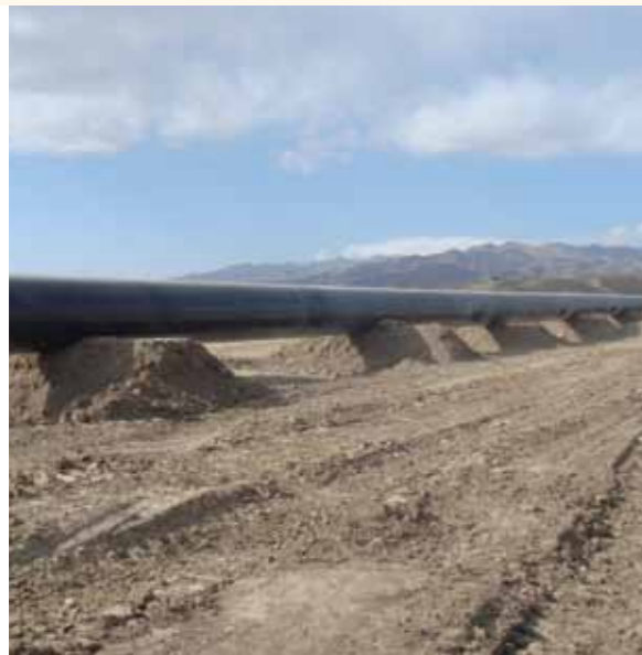
宝钢UOE焊管成功应用于西气东输二线工程
