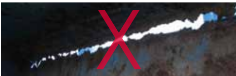
不规范：舱盖严重锈蚀，密封性差
