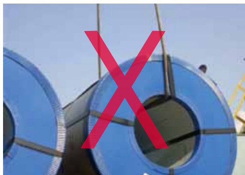
不规范照片：用钢丝绳直接吊装
