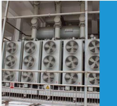
保变——三峡地下电站 SFP-840MVA/500KV
