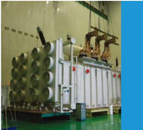
沈变——华润湖北 SFP-1140MVA/500KV
