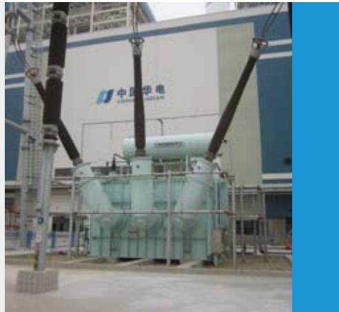
沈变——莱州 DFP-380MVA/500KV
