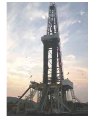
元坝102-2H钻井平台
